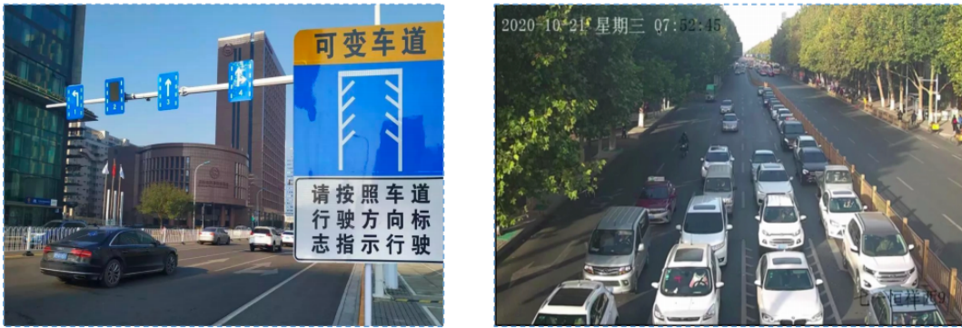
图 14 保定市可变车道与信号灯联动控制
